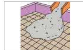
콘크리트를 타설하다 mengecor beton
