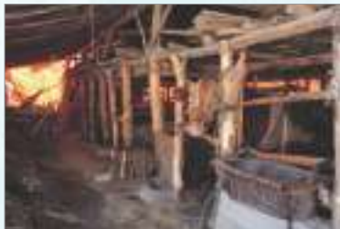
축사 ຄອກລ້ຽງສັດ ສຸດທ້າຍ ທີ່ເຮັດວຽກ ຫຼື ສຸດທ້າຍ ກວດສອບ ຫຼື ສ້ອມແປງຫຼັງຄາຄອກລ້ຽງສັດ.
